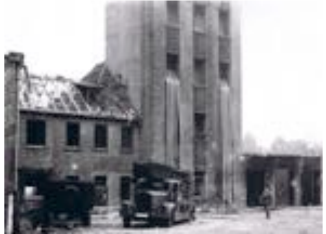
Feuerwache 2 nach einem Bombenangriff 1943
