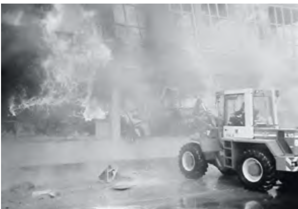
Der Rala im Einsatz bei einem Brand eines Möbelhauses (Foto FWDO)
