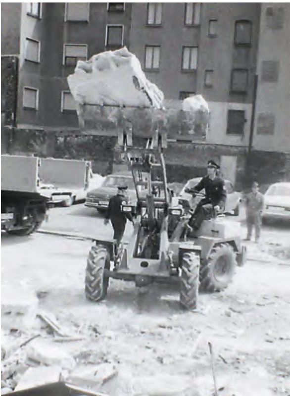
Der Rala beim Abriss eines Schuppens auf dem neuen Gelände der FW1 (Foto FWDO)
