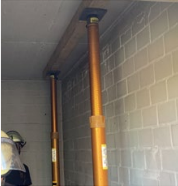
Abb. 9 Rettungsstützen in Senkrechtem Einbau zum Abfangen einer Garagendecke. Die Füße und Köpfe werden verschraubt. Foto Siekaup
