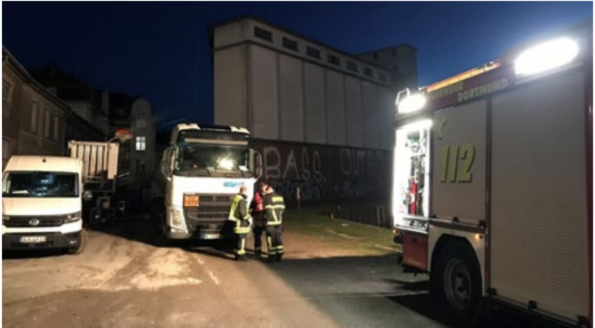
Einsatzstelle am Samstagabend 27. Januar 2024. In der Bildmitte hinten das Silogebäude, davor das erste Tankfahrzeug mit Flüssigstickstoff und im Bild links die errichtete Verdampferanlage zur Erzeugung gasförmigen Inertgases (Foto: ©Barth)
