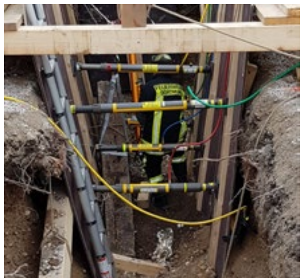
Abb. 8 Sicherung einer Baugrube durch die SE-B mithilfe mehrerer Rettungsstützen, Rettungstafeln, Niederdruck-Kissen und Kanthölzern. Foto Pufahl
