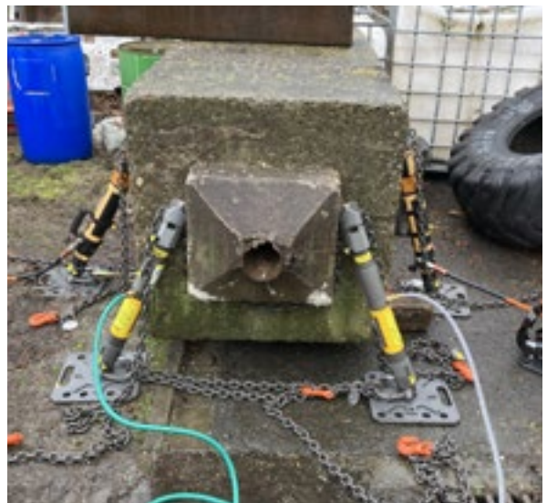
Abb. 13 Da kein geeigneter Anschlagpunkt an der flachen Oberfläche vorhanden ist, kann der Kettenkopf mit untergezogener Kette genutzt werden. Die Rettungsstützen sichern den Hub durch konstantes Nachfahren. Foto Siekaup
