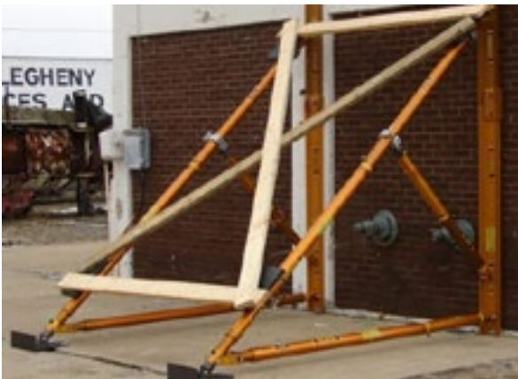
Abb. 10 Stützbock zum Abstützen von Wänden. Foto Paratech
