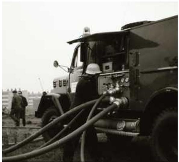
Der Pumpenbedienstand auf der Fahrerseite des Fahrzeuges
