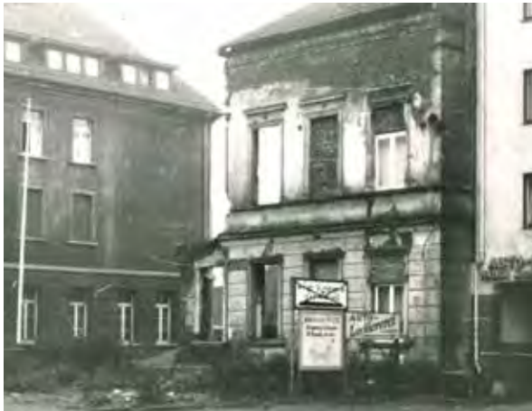
Abb. 7: Das beschädigte Gebäude der Feuerwehrsule neben der Nordwache kurz vor dem Abriss Anfang der 1970er Jahre
