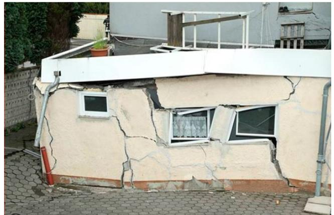
Abb. 5+6: zunehmende Schäden an einem Gebäude durch Absacken (Fotos: Feuerwehr Dortmund)
