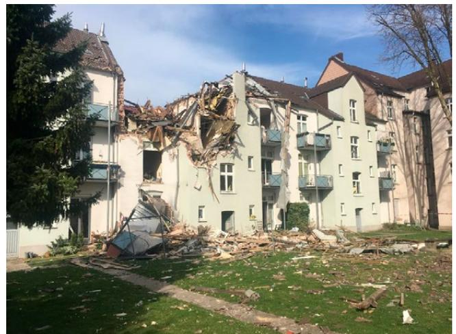
Abb. 3: Verlust von tragenden Wänden (Foto: Feuerwehr Dortmund)
